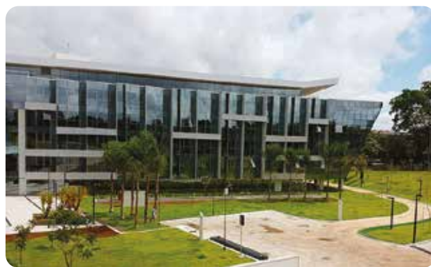
Sede da entidade, Edifício ÍON é um dos novos marcos arquitetônicos de Brasília
